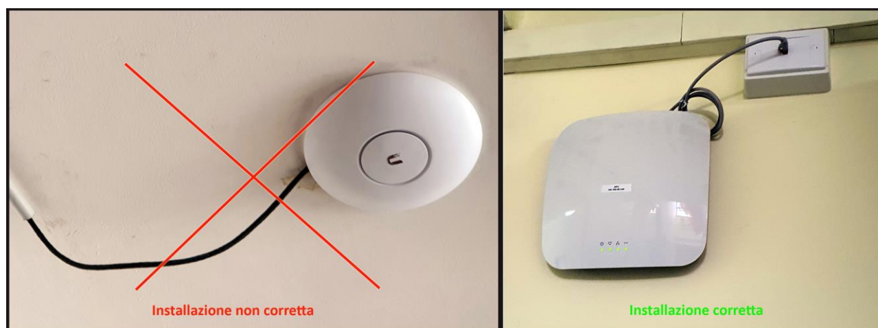
Figura 10 – Installazione corretta dell'Access Point
